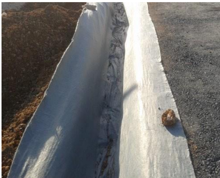
Figura - Colocação da manta geotêxtil.
