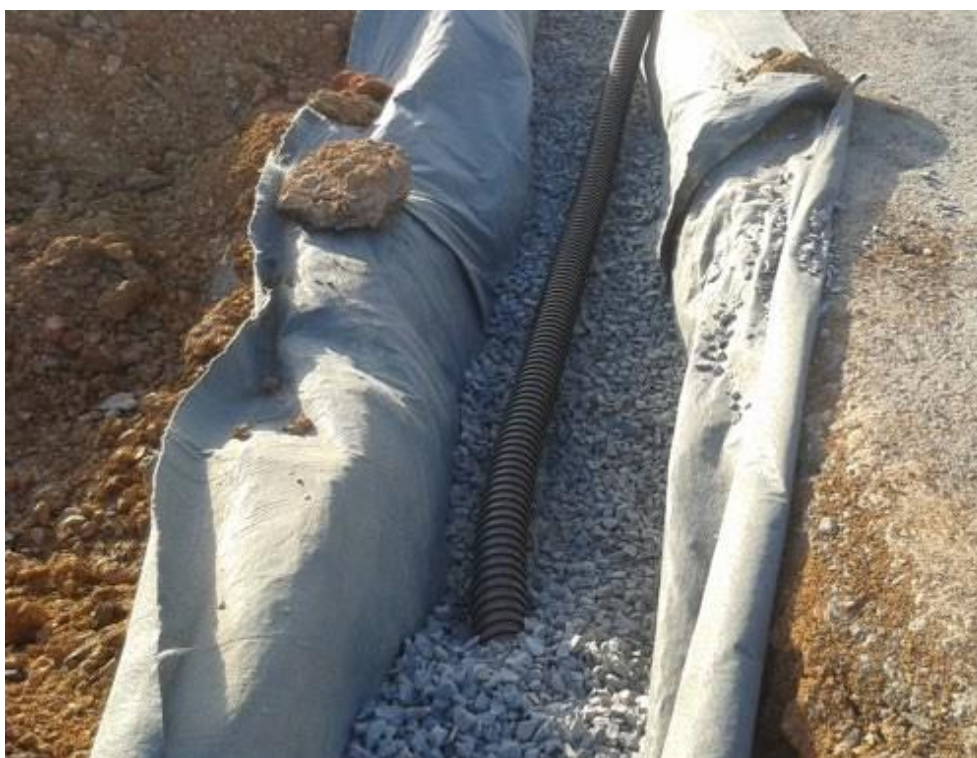
Colocação da brita sobre a manta geotêxtil.
